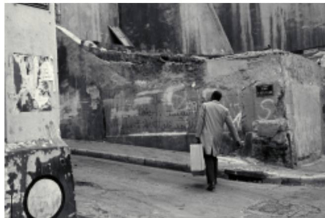
Dans le quartier de la Butte des Carmes en rénovation, Marseille, 1975
